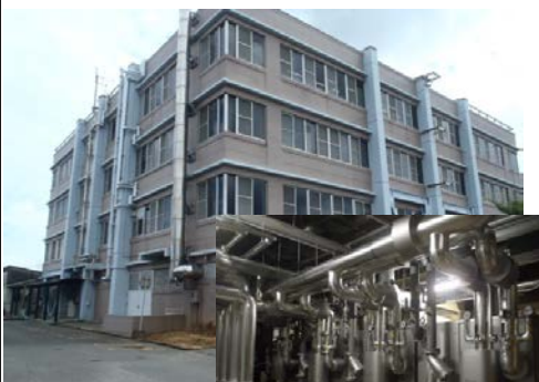
天草総合庁舎空調設備改修工事
